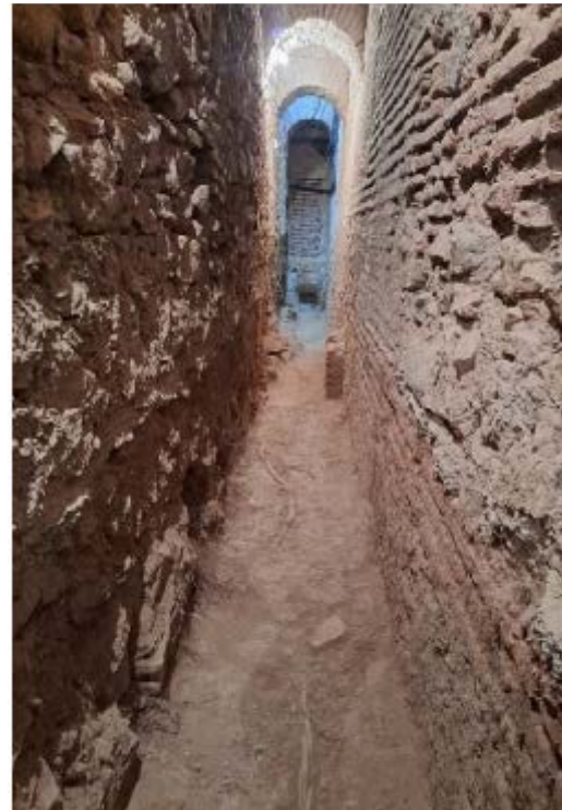
Vista mina lateral Iglesia tras retirada de rellenos.
