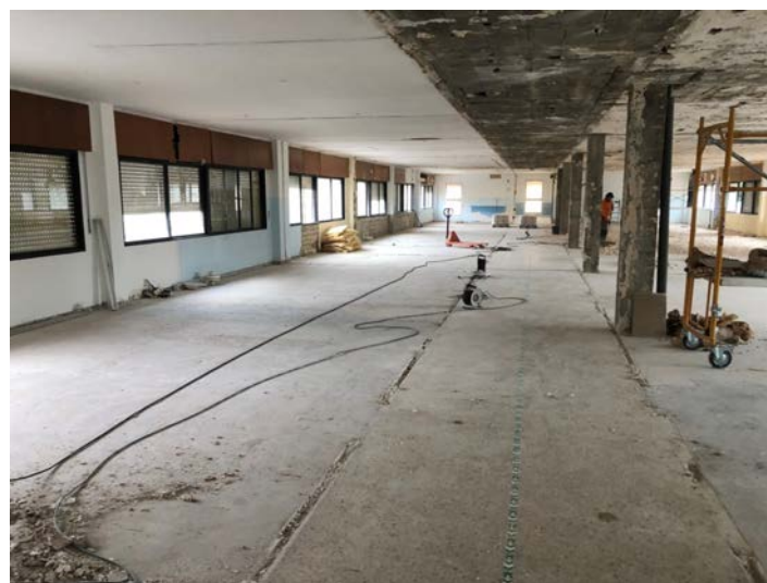
Estado en ejecución
