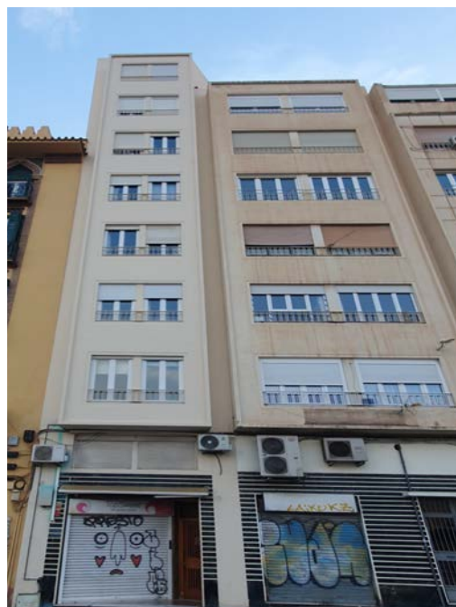
Avenida de la Rosaleda nº 2
