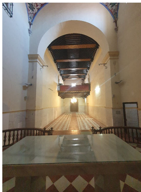
Vista general nave central finalizada.
