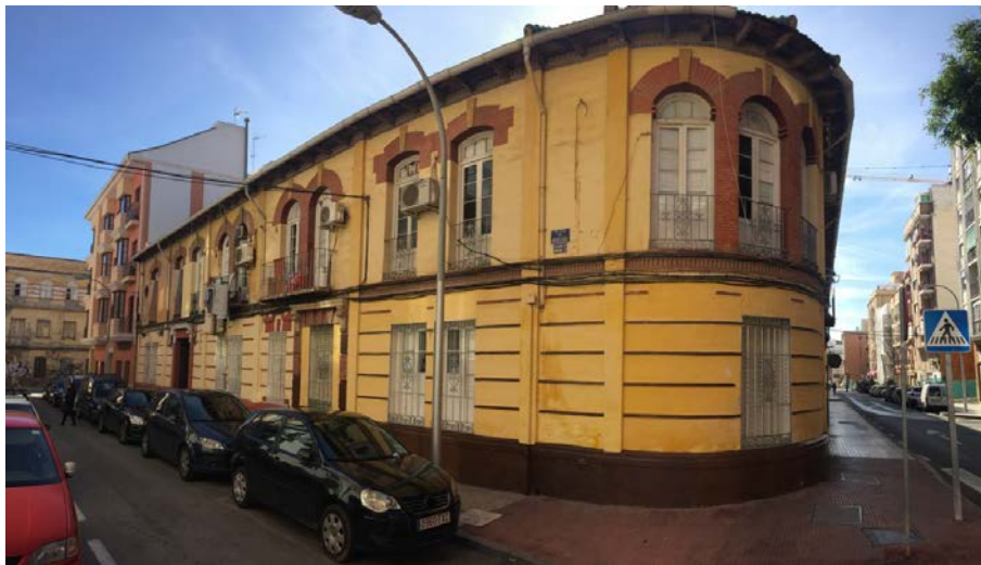
Fotografías del estado actual
