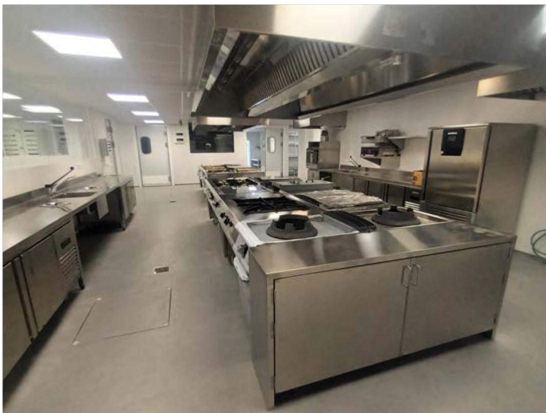
Imagen 2. Aula de cocina con hall de acceso y cuarto frío al fondo. Estado final de obra
