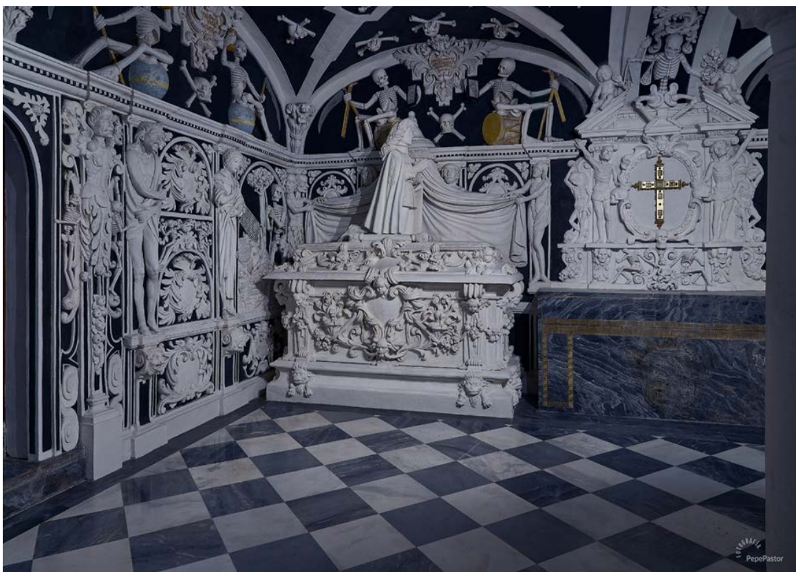
Estado final de la rehabilitación del Panteón. Fuente: Pepe Pastor.
