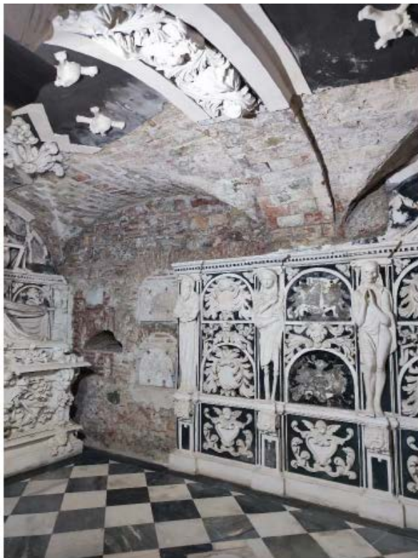
Zona intervenida en 2021 "Testero noroeste"
