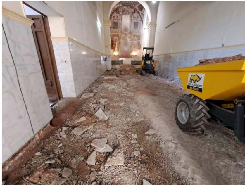
Trabajos de eliminación de solería superpuesta.
