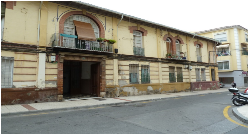
Fotografías del estado actual
