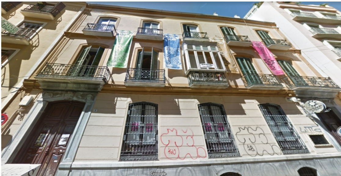
Fotografía fachada principal C/ Nosquera nº 9-11
