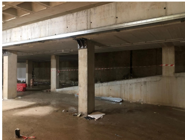
C/ Ingeniero José María Garnica, Nº8, 29002 - Málaga; Garajes 02 y 03 Estado actual
