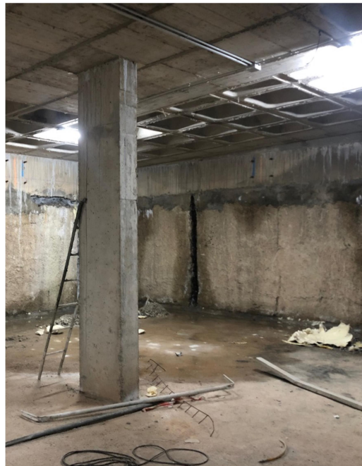
C/ Ingeniero José María Garnica, Nº8, 29002 - Málaga; Garaje 34 - Estado actual
