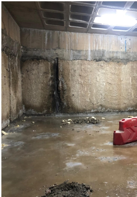
C/ Ingeniero José María Garnica, Nº8, 29002 - Málaga; Garaje 12 - Estado actual
