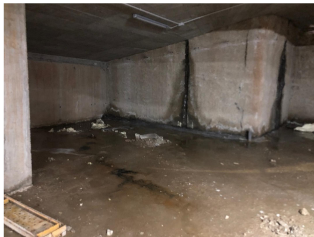
C/ Ingeniero José María Garnica, Nº8, 29002 - Málaga; Garajes 05 y 06 Estado actual
