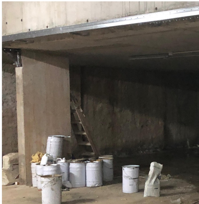
C/ Ingeniero José María Garnica, Nº8, 29002 - Málaga; Garaje 35 Estado actual
